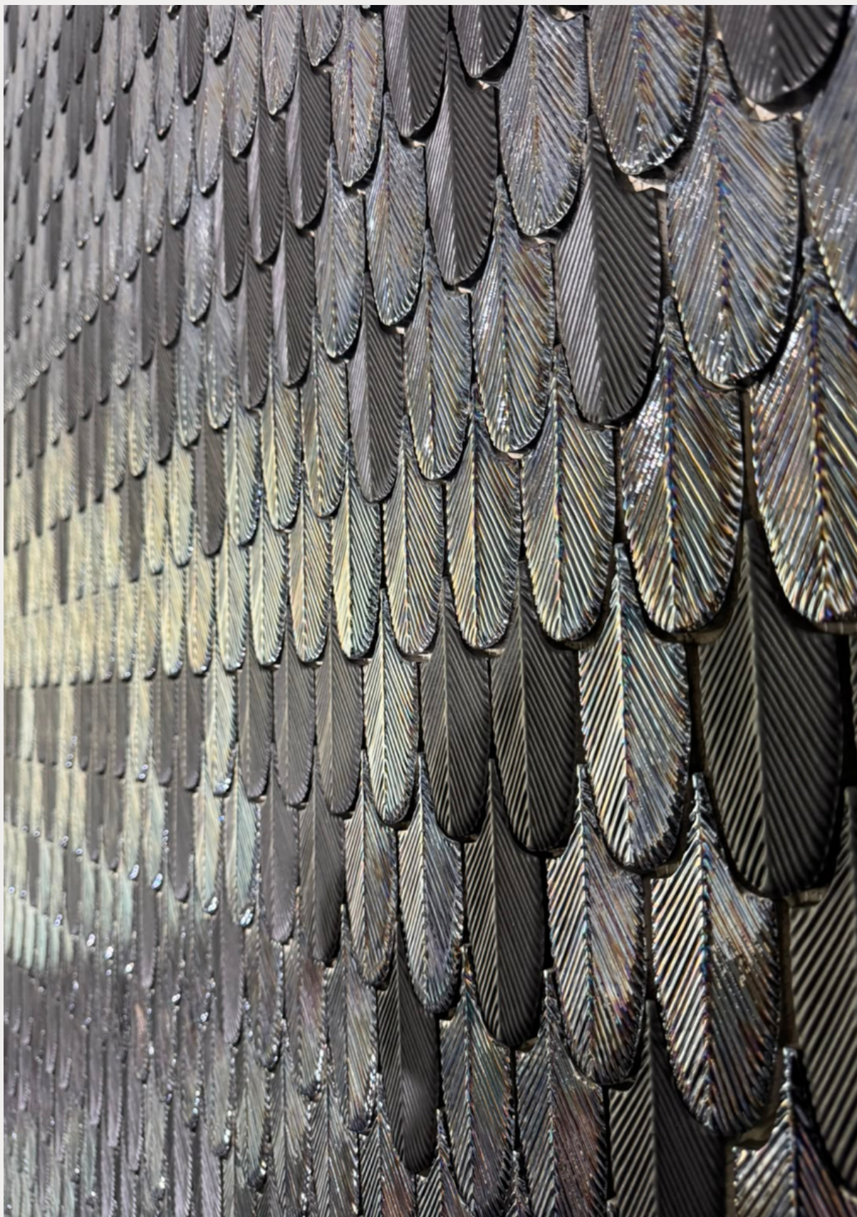
MOSAIKFLIESEN IN FEDERFORM, SCHUPPENARTIG ÜBERLAPPEND VERLEGT.
